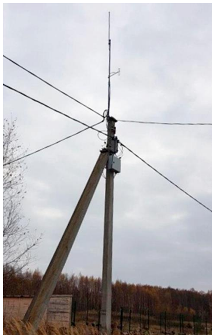
Рис. 4 Пример установки УСПД на опору ВЛ
